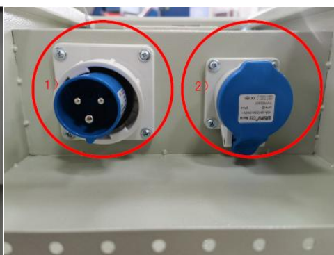
图 2. 电箱底部进出口线口图示 1) 15A/220V 电箱进线端口 2) 15A/220V 电箱出线端口
